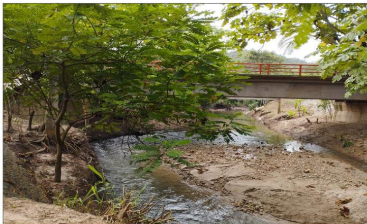
FIGURA N°01: QUEBRADA SERRANO, UBICADA EN EL DISTRITO DE SAPOSOA, PROVINCIA HUALLAGA - SAN MARTIN. TRAMO CRITICO A INTERVENIR DONDE SE APRECIA COLMATACION DE CAUCE DE LA QUEBRADA Y EROSION EN EL TALUD DE LA RIBERA.
